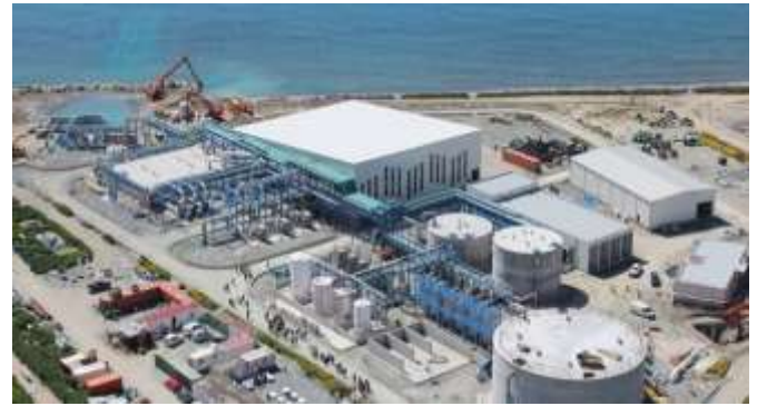
Usine de Dessalement, Agadir
